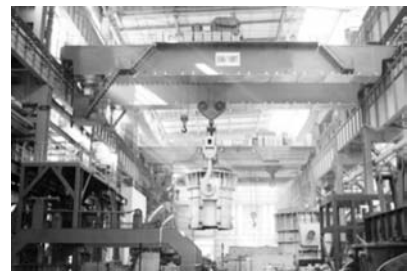
图1 铸造起重机钢包吊运系统
