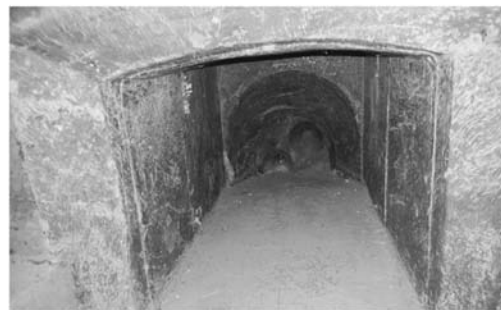
(b) 过料区实况
